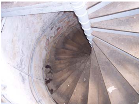
Bild 3 Wendeltreppe im Turminneren
