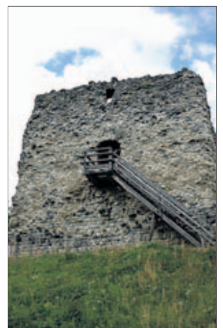
Der Turm der Burgruine Freienstein wurde vorbildlich konserviert und wird dem unteren Tösstal noch lange als Wahrzeichen erhalten bleiben. (ost)
